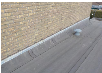
bitumen langs dakrand, overzicht
