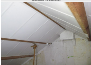
Julianalaan 1 te Beusichem
