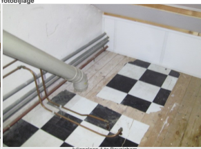
Julianalaan 1 te Beusichem
