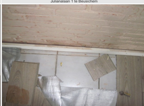
Julianalaan 1 te Beusichem
