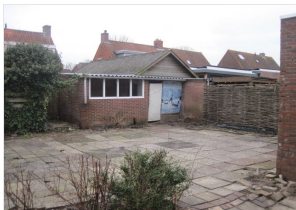
Julianalaan 1 te Beusichem
