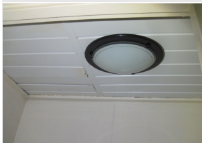
Julianalaan 1 te Beusichem
