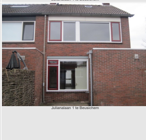
Julianalaan 1 te Beusichem
