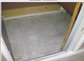
Julianalaan 1 te Beusichem
