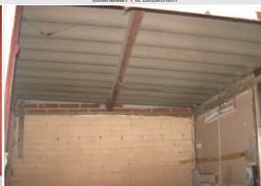
Julianalaan 1 te Beusichem
