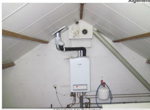
Julianalaan 1 te Beusichem
