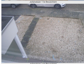
Julianalaan 1 te Beusichem
