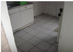
Julianalaan 1 te Beusichem
