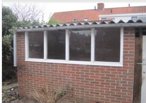
Julianalaan 1 te Beusichem
