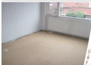
Julianalaan 1 te Beusichem
