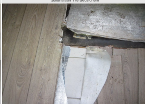
Julianalaan 1 te Beusichem
