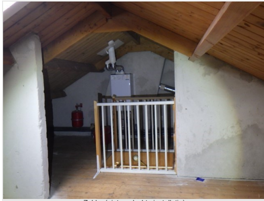
Zolder (niet verdachte installatie)
