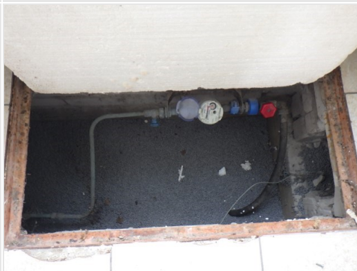
Kruipruimte met isolatiekorrels
