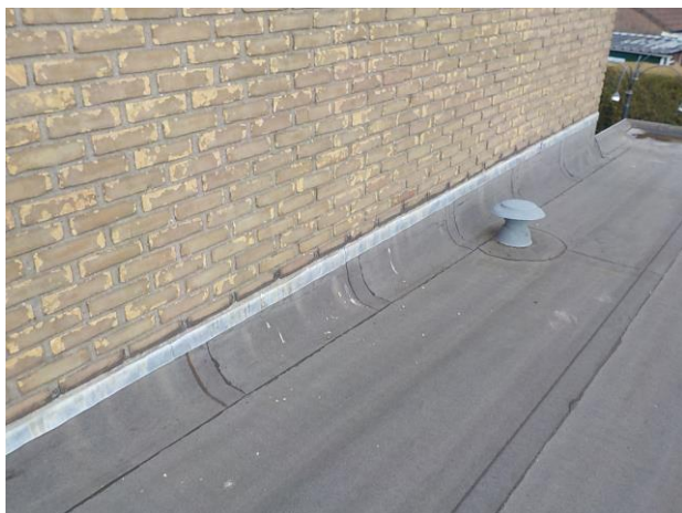
bitumen langs dakrand, overzicht
