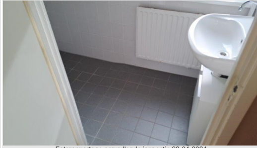
Fotorapportage aanvullende inspectie 22-04-2024
