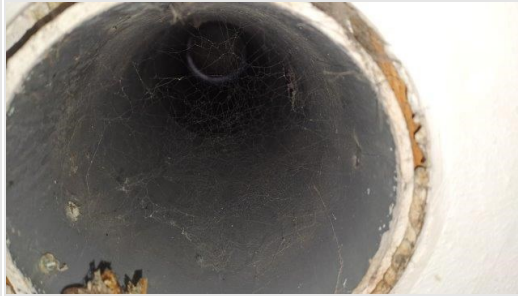
Fotorapportage aanvullende inspectie 22-04-2024
