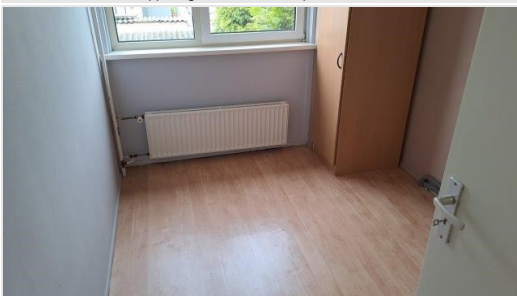
Fotorapportage aanvullende inspectie 22-04-2024
