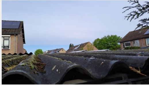
Fotorapportage aanvullende inspectie 22-04-2024
