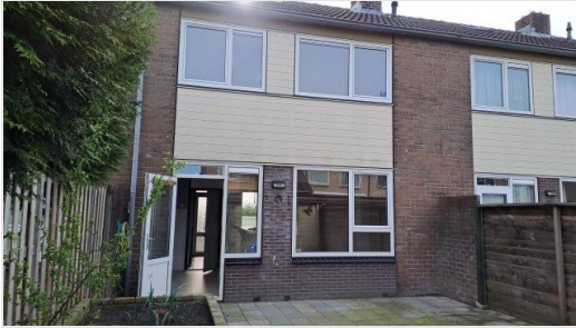
Fotorapportage aanvullende inspectie 22-04-2024
