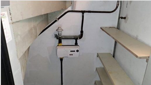
Fotorapportage aanvullende inspectie 22-04-2024
