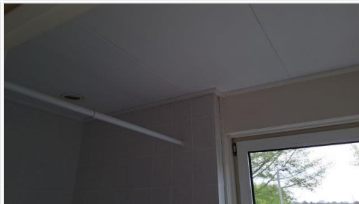
Fotorapportage aanvullende inspectie 22-04-2024
