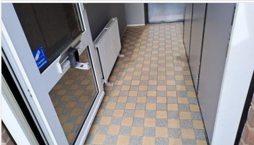
Fotorapportage aanvullende inspectie 22-04-2024
