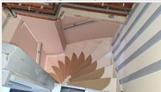
Fotorapportage aanvullende inspectie 22-04-2024
