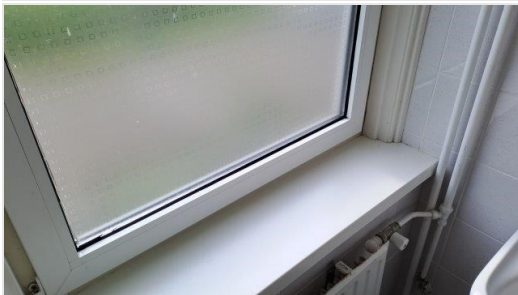
Fotorapportage aanvullende inspectie 22-04-2024
