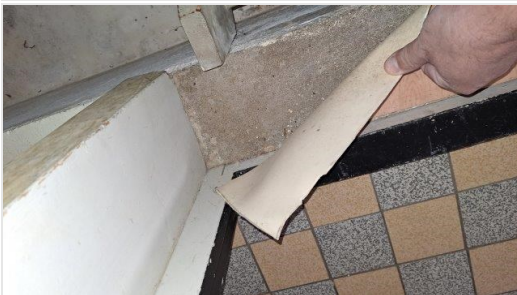
Fotorapportage aanvullende inspectie 22-04-2024
