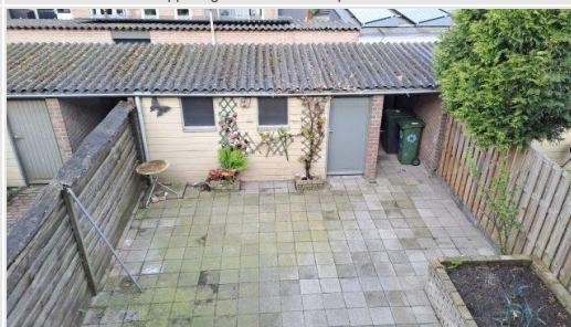
Fotorapportage aanvullende inspectie 22-04-2024
