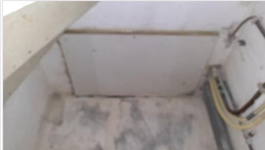
Fotorapportage aanvullende inspectie 22-04-2024
