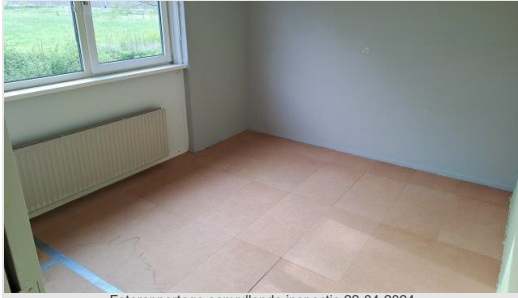
Fotorapportage aanvullende inspectie 22-04-2024
