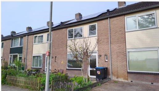
Fotorapportage aanvullende inspectie 22-04-2024
