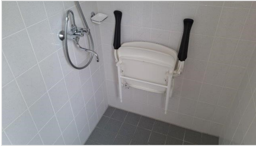
Fotorapportage aanvullende inspectie 22-04-2024
