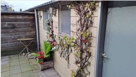
Fotorapportage aanvullende inspectie 22-04-2024
